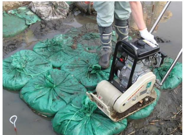
写真-2 沼地上の高規格連結土のうの転圧状況
