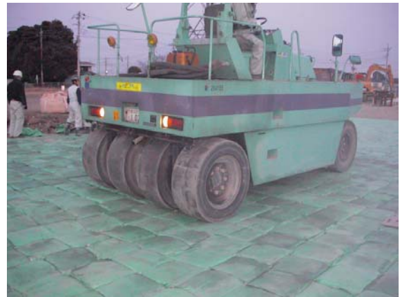
写真-4 12tタイヤローラーで転圧中の角土のうの最上面
