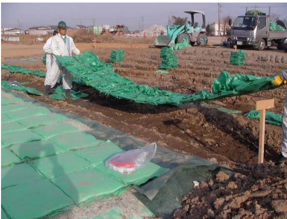
写真-2 ガイドゲージ付き高規格連結土のうの作業状況
