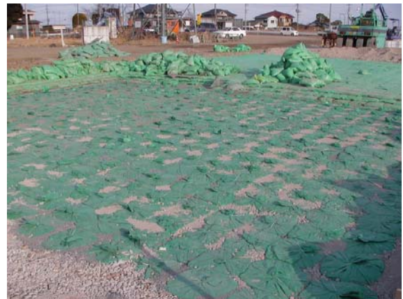
写真-3 ガイドゲージ付き高規格連結土のうの設置状況
