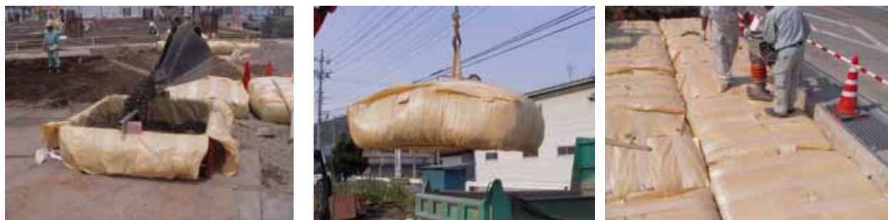
1)重機を使い上部より資材を投入し上面を閉口 2)LSを吊上げ移動し所定位置に設置 3)敷設後十分転圧を行い設置完了
