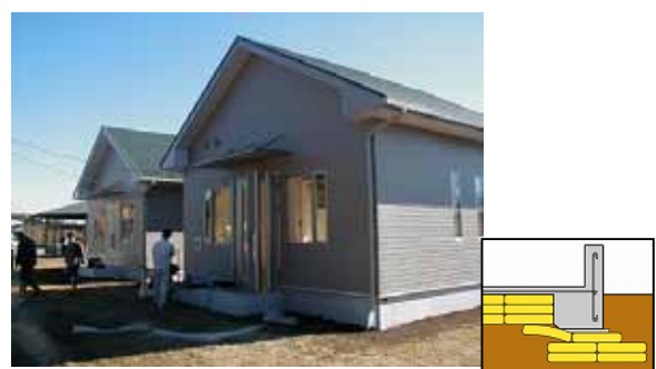
写真-4 改悪された地盤上に建設された 2 棟の建物 (土のう有り無し) と土のう積層体の配置図
