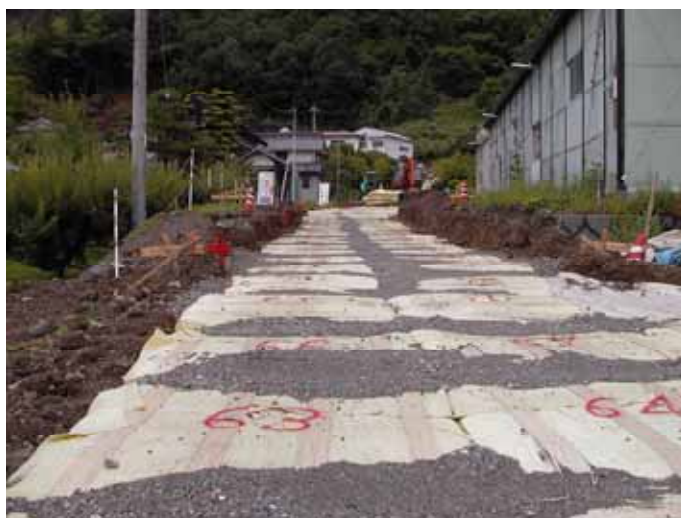
写真 - 12 D・BOX 工法 (LS150) の施工状況
