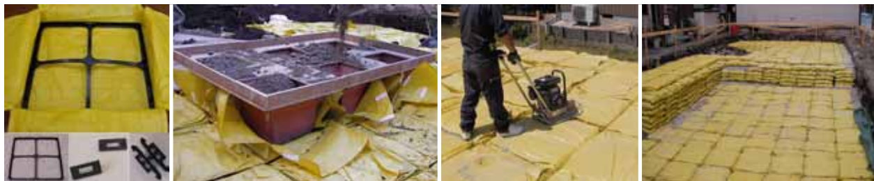
1)使用されるパーツ 2)上部より資材投入し袋を閉口 3)転圧 4)設置完了
